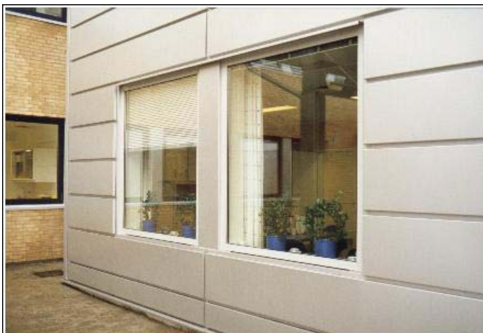
Indbygget persienne Roskilde Amtssygehus, Roskilde Hagen
