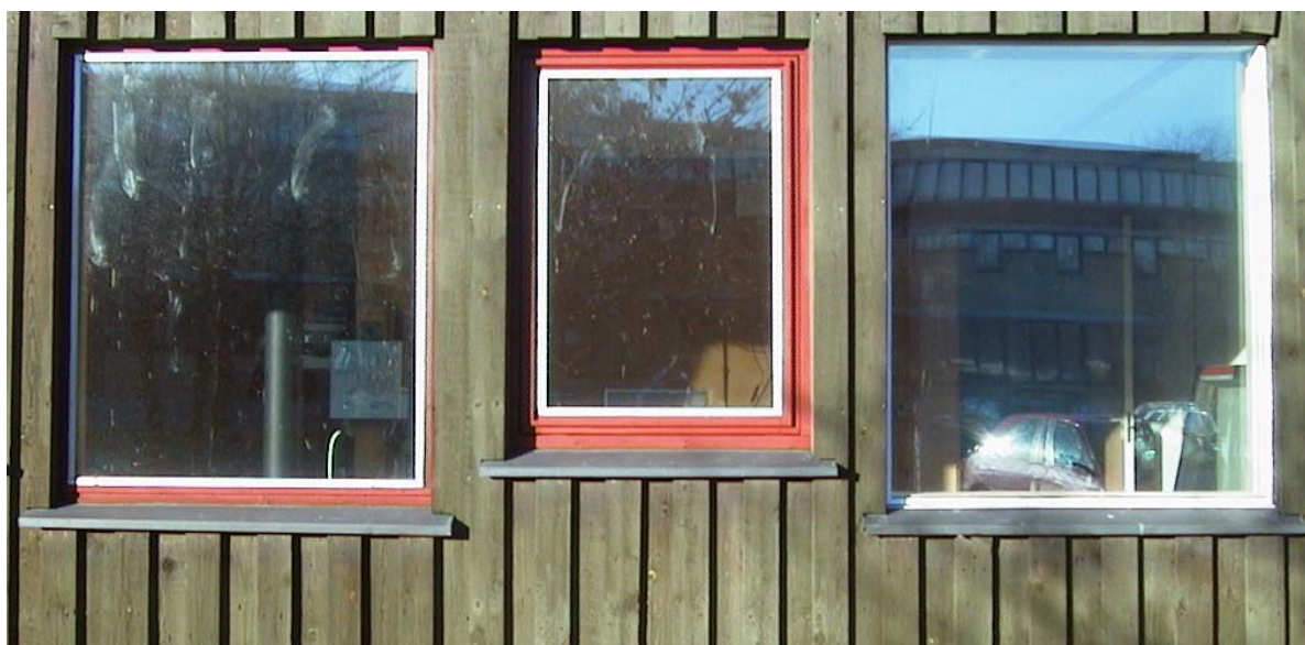
Figur 3.13 Foto af testvindue (højre) baseret på det nye koncept. Vinduet er monteret i BYG•DTU's eksperimenthus for videre observationer og målinger i vinduet.
