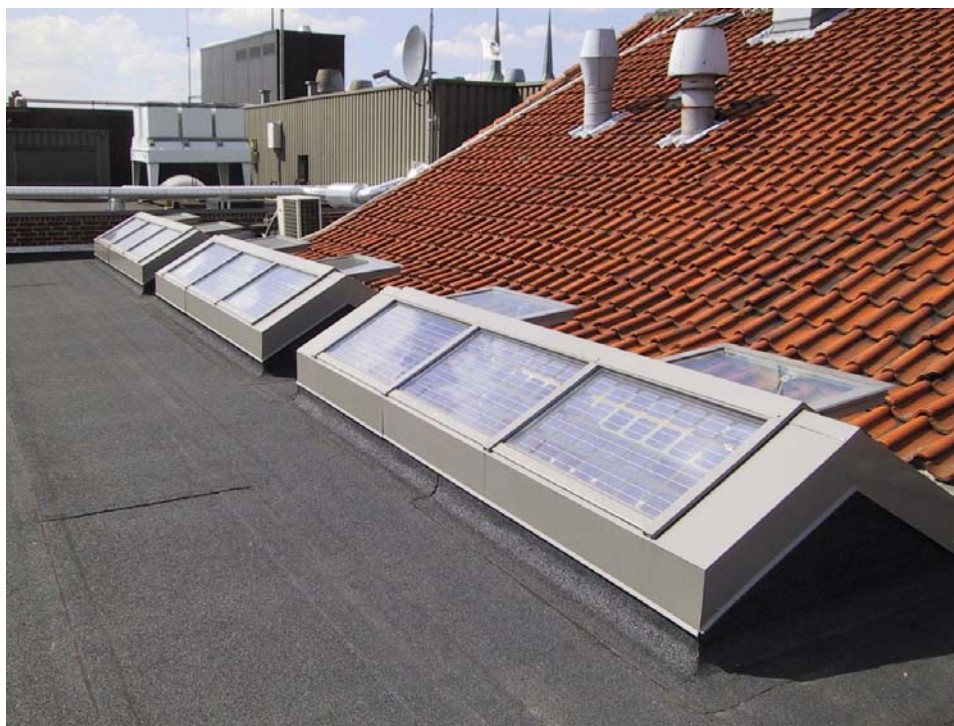
Figur 4.1 Ovenlysvinduer med monokrystallinske solceller på Roskilde Bank
